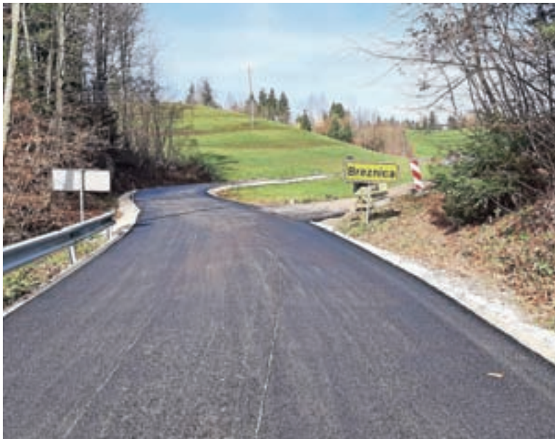
Obnovo je dočakala tudi cesta na Breznici.
