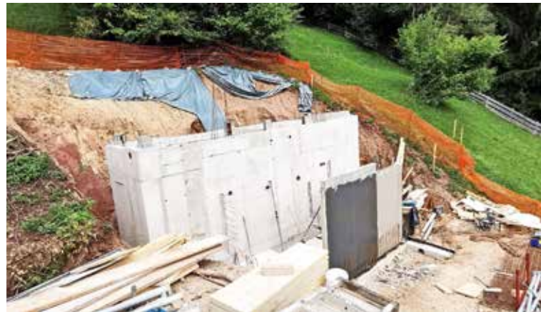
Gradnja vodohrana v Srednjem Vrhu
