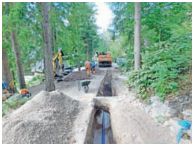
Zamenjava vodovodne cevi dolžine 270 metrov na Gobeli v Gozdu - Martuljku / Foto: arhiv Komunale Kranjska Gora
