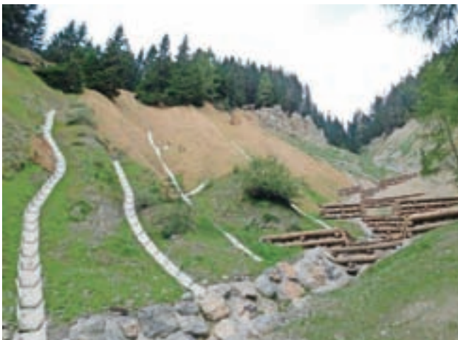
Sanacija plazu Jurež / Foto: arhiv Komunale Kranjska Gora
