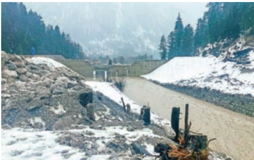
Na območju Belce so v minulih dveh letih izvedli tudi dela za stabilizacijo struge in zagotavljanje pretočnosti vodotoka. / Foto: Blaž Lavtižar, poveljnik CZ Kranjska Gora
