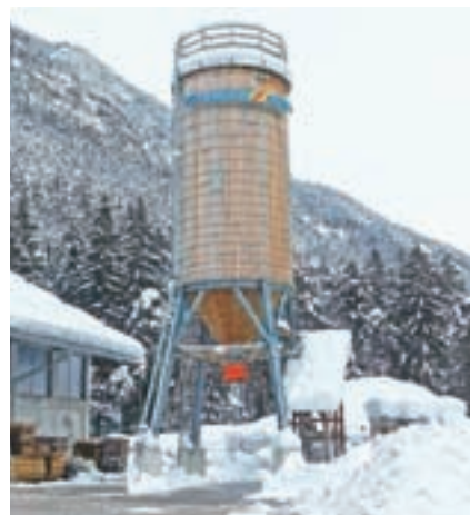
Računalniško vodeni silos za sto ton soli / Foto: Blaž Knific
