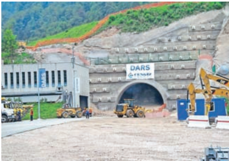
Drugo cev bodo zgradili vzhodno od sedanje.
