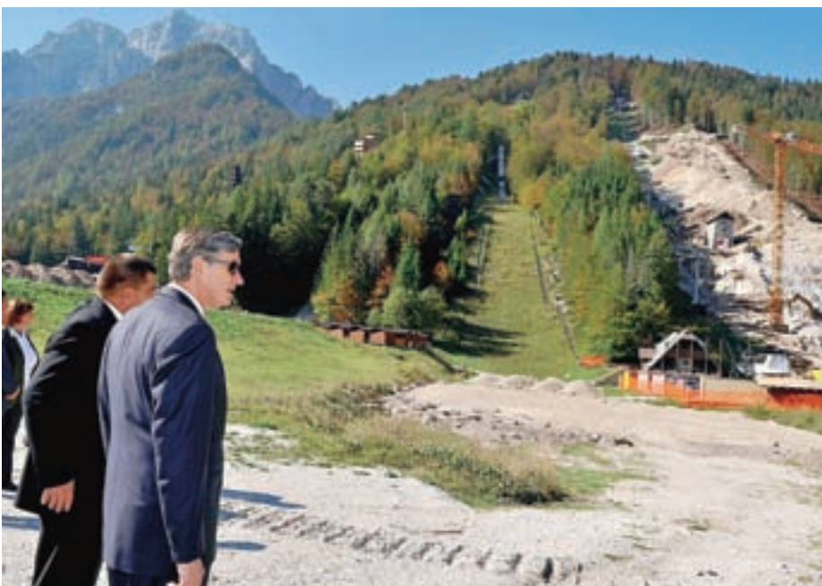
... in gradbena dela na Bloudkovi velikanki.
