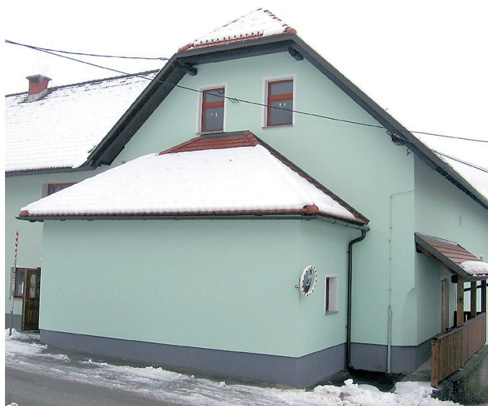
Obnovljeni kulturni dom na Dovjem
