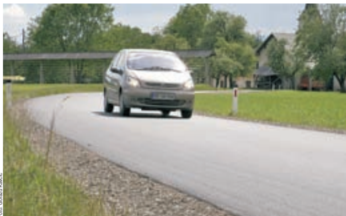
Obnovljen cestni odsek na Beli
