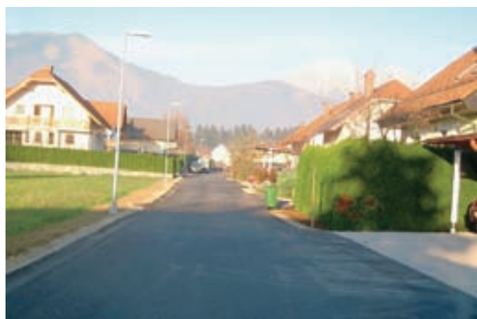
Asfaltiranje ulice na severu Britofa
