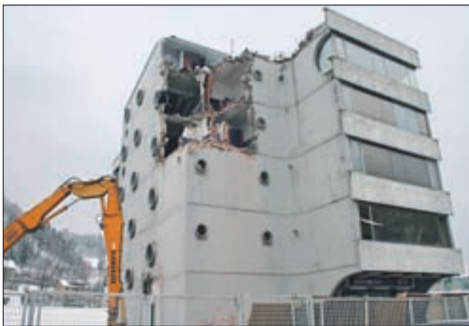
Začetek rušenja novejšje upravne stavbe - stolpiča (15. 1. 2010)
