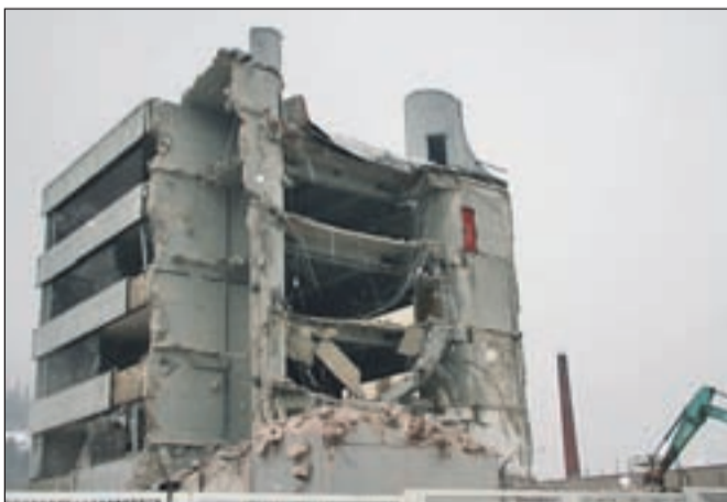
Podiranje železo-betonke zgradbe je bilo zamudno (25. 1. 2010).
