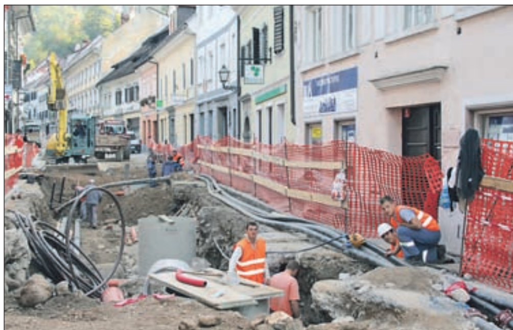
Trenutno potekajo obnovitvena dela na spodnjem delu Trga svobode v Trzinu.
