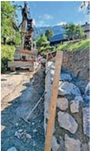
Novi oporni zid na Zgornjem Vetrnem
