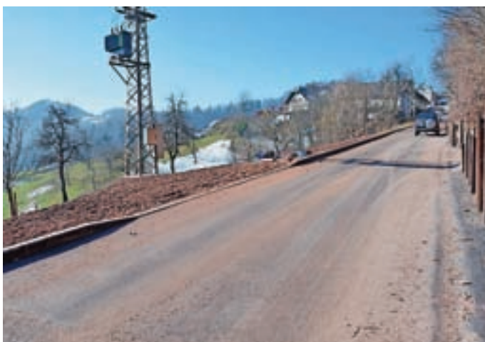
Sanacija spodnjega plazu v Studenčičah je zaključena. / Foto: arhiv Občine Medvode
