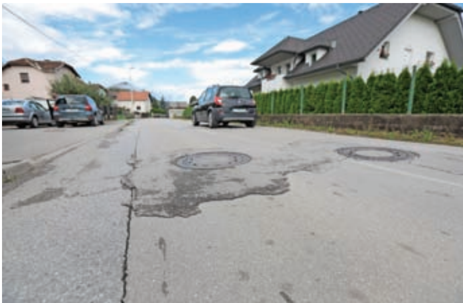
Sanacija ceste Rakovnik–Goričane bo potekala v dveh fazah.
