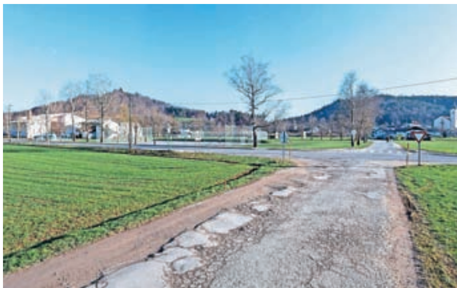
Rekonstrukcija ceste od Smlednika proti Dragočajni je trenutno načrtovana za leto 2021. Občina Medvode skupaj z Direkcijo RS za infrastrukturo načrtuje tudi ureditev krožišča pri šoli. / Foto: Peter Košenina
