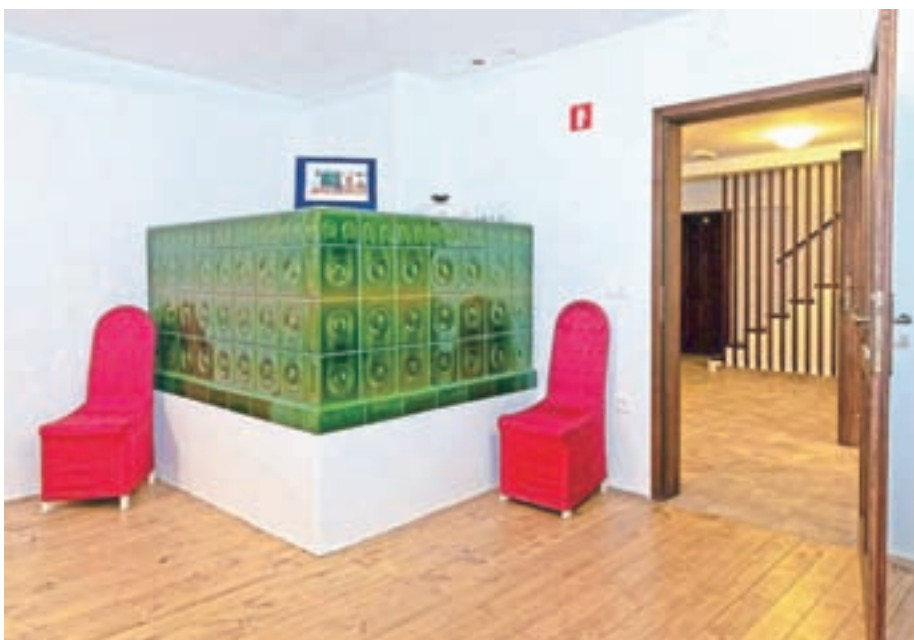
V sklopu zadnje prenovitve je bila v hiši zgrajena krušna peč.
