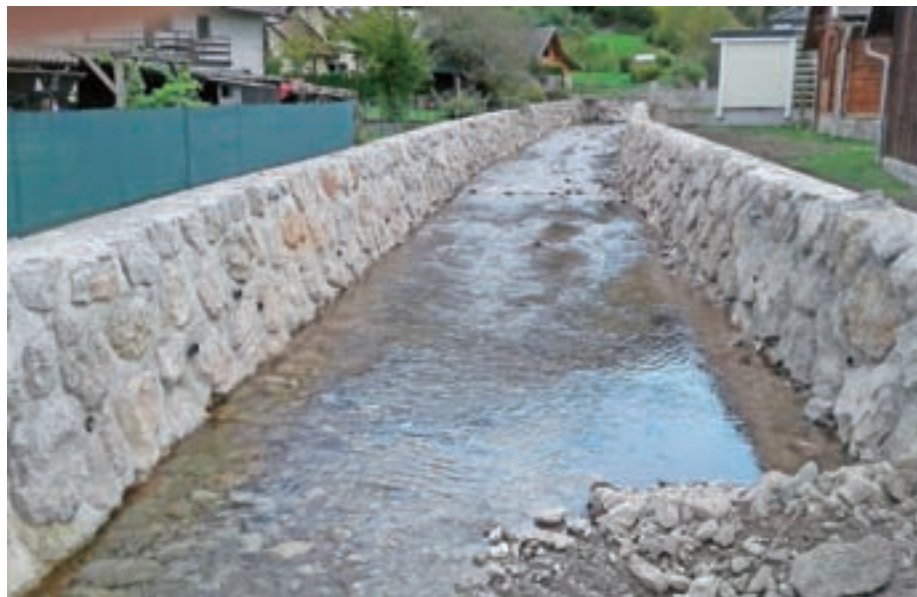
Pretekli mesec so bila zaključena dela na odseku struge vodotoka Ločnica v Sori.
