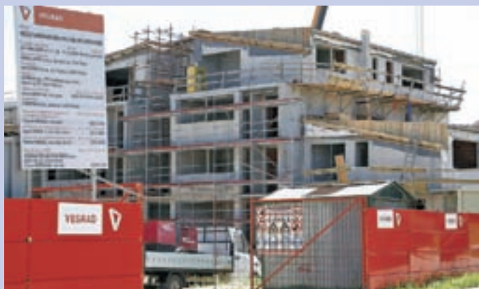
Večstanovanjski objekt Na Klancu bo zaključen do konca leta.
