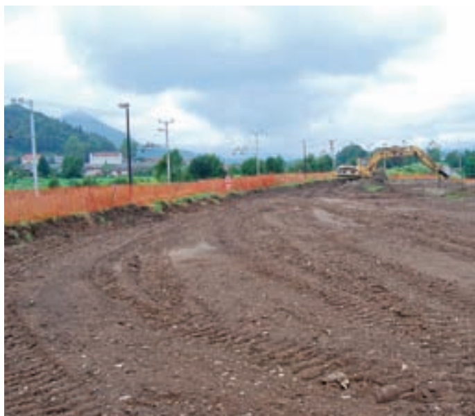
Začela so se pripravljala dela za gradnjo športnega parka, v prvi fazi pripravljala dela za gradnjo pomožnega nogometnega igrišča.
