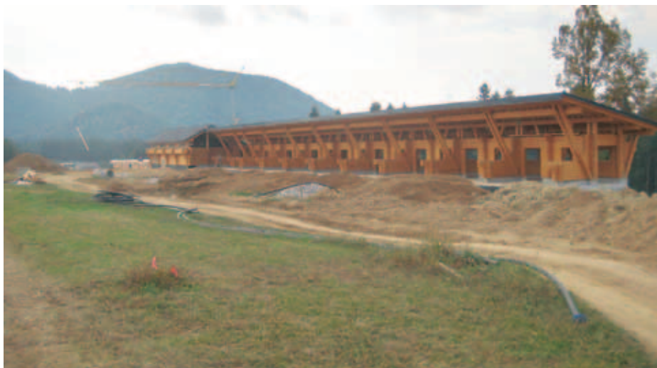
Dva objekta sta zgrajena, trenutno gradijo tretjega, ki bo klubski objekt. Spodaj bodo garderobe, v srednjem delu restavracija in kuhinja, zgoraj pa klubski prostor, pisarne in poslovni kotiček.
