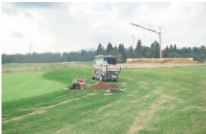
Travnata površina je že skoraj pripravljena.
