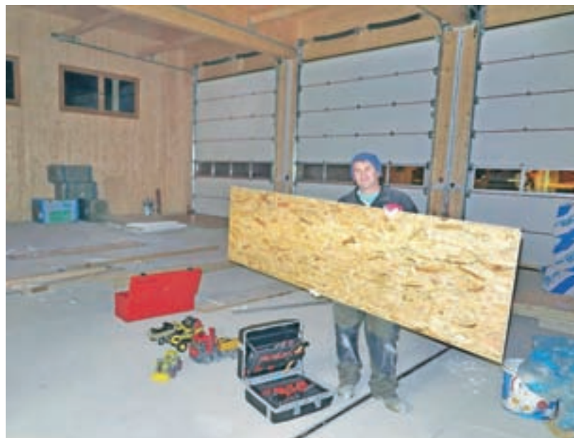
Selški gasilci so v gradnjo novega doma vložili že 3700 prostovoljnih ur.
