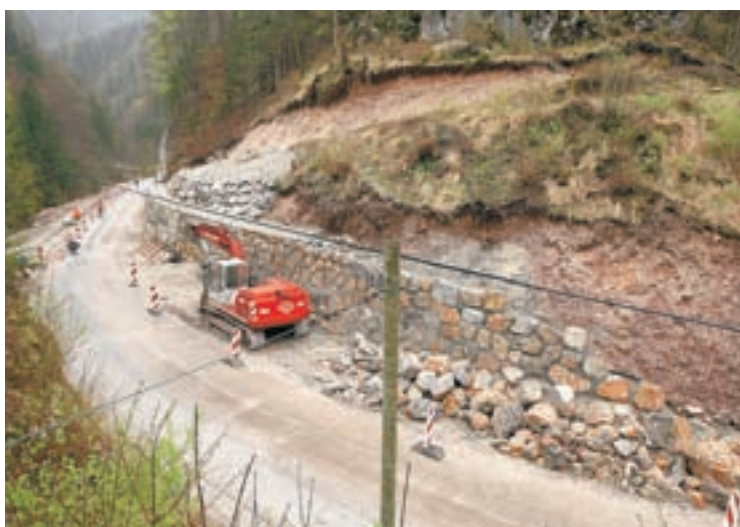
Gradnja na regionalni cesti Kranj - Jezerški vrh pri Hubertovi kapeli / Foto: Gorazd Kavčič
