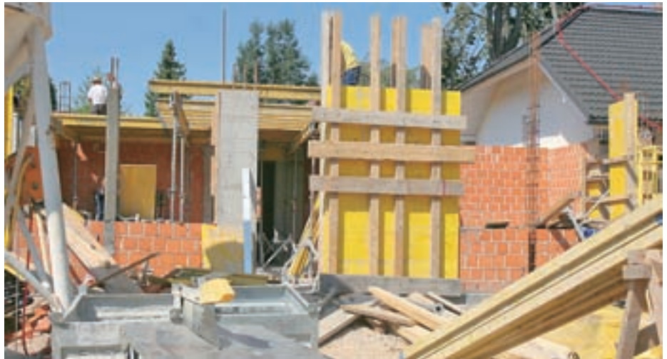
Prizidek k vrtcu v Cerkljah bodo po županovih napovedih zgradili do pomladi.
