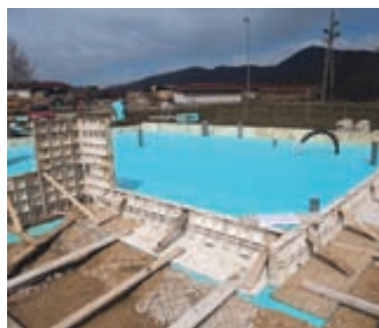
Drugi sloj toplotne izolacije FIBRANxps 400-L ščiti hidroizolacijo pred poškodbami. Položen je v opaž temeljne plošče
