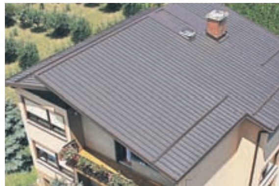
Trapezni profil s 3 cm izolacije iz poliuretana
