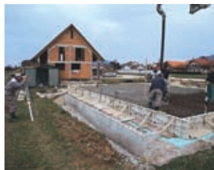
Betonaža temeljne plošče.
