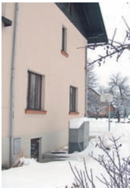
Hiša iz leta 1931, brez izolacije. Prej so lastniki porabili približno 3.500 litrov kurilnega olja, danes porabijo slabih 14 tisoč kilovatnih ur električne energije.
