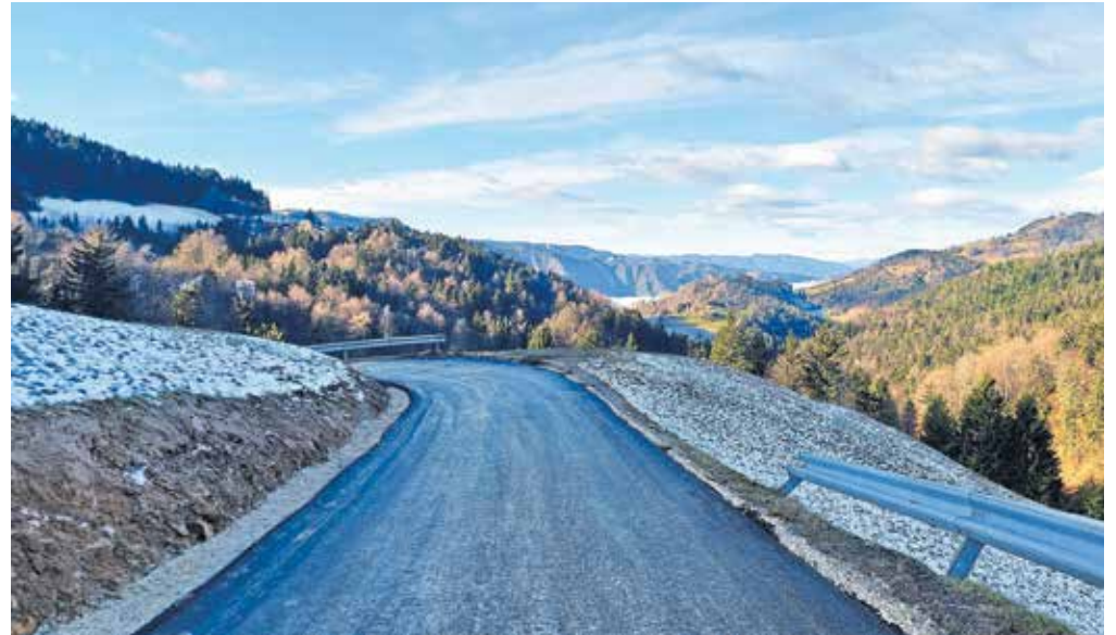
Obnovljeni odsek ceste v Javorjevem Dolu / FOTO: ARHIV OBČINE
