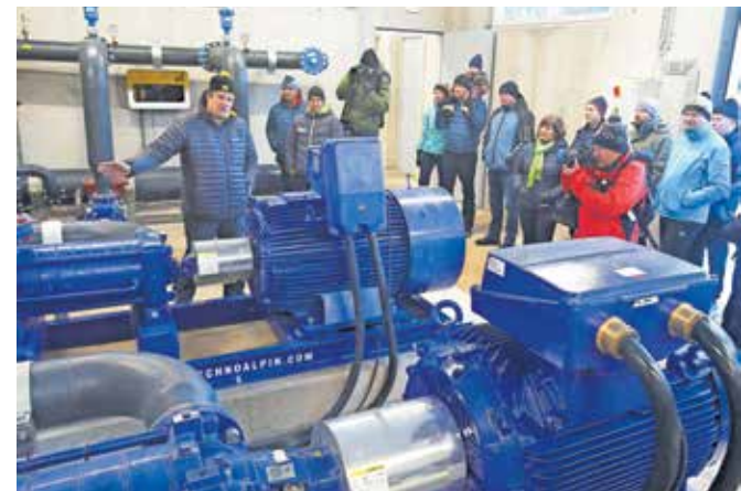
V sklopu zasneževalnega sistema so na Soriški planini uredili tudi sodobno črpališče za vodo. / FOTO: GORAZD KAVČIČ
