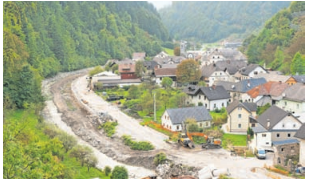
Protipoplavnim ukrepom na Selški Sori mimo starega dela Železnikov sledi še gradnja obvoznice, ki bo potekala na obrežnem zidu. / FOTO: SIMON BENEDIČIČ
