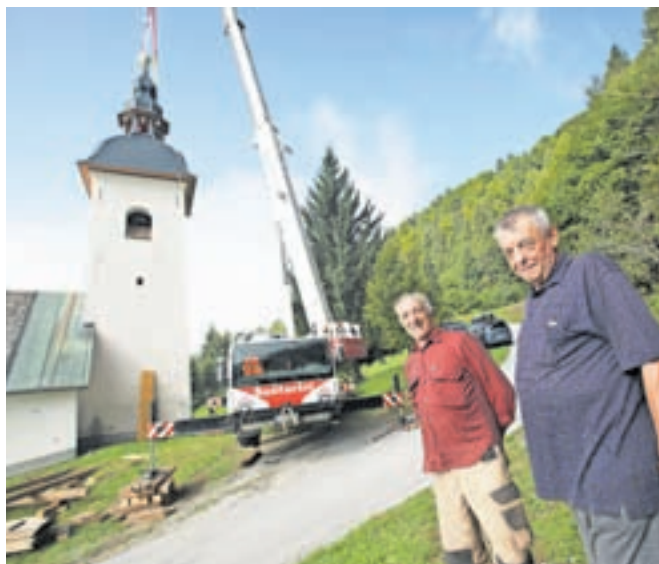
Najbolj zahteven del je bil dvig strešne kupole, težke kar štiri tone, na vrh štirideset metrov visokega zvonika. / FOTO: GORAZD KAVČIČ
