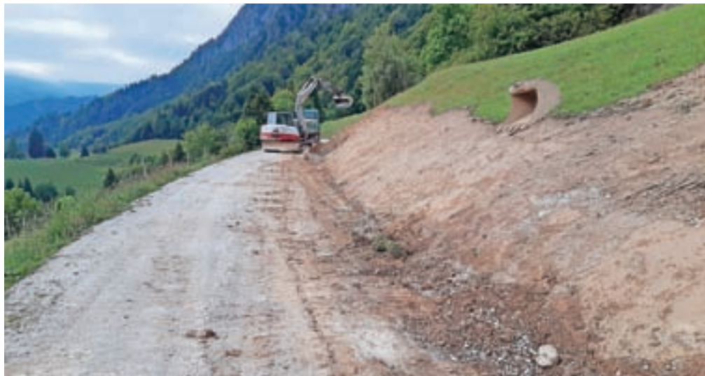
Urejanje cestnega odseka Torka–Zabrdo / FOTO: ROK PINTAR
