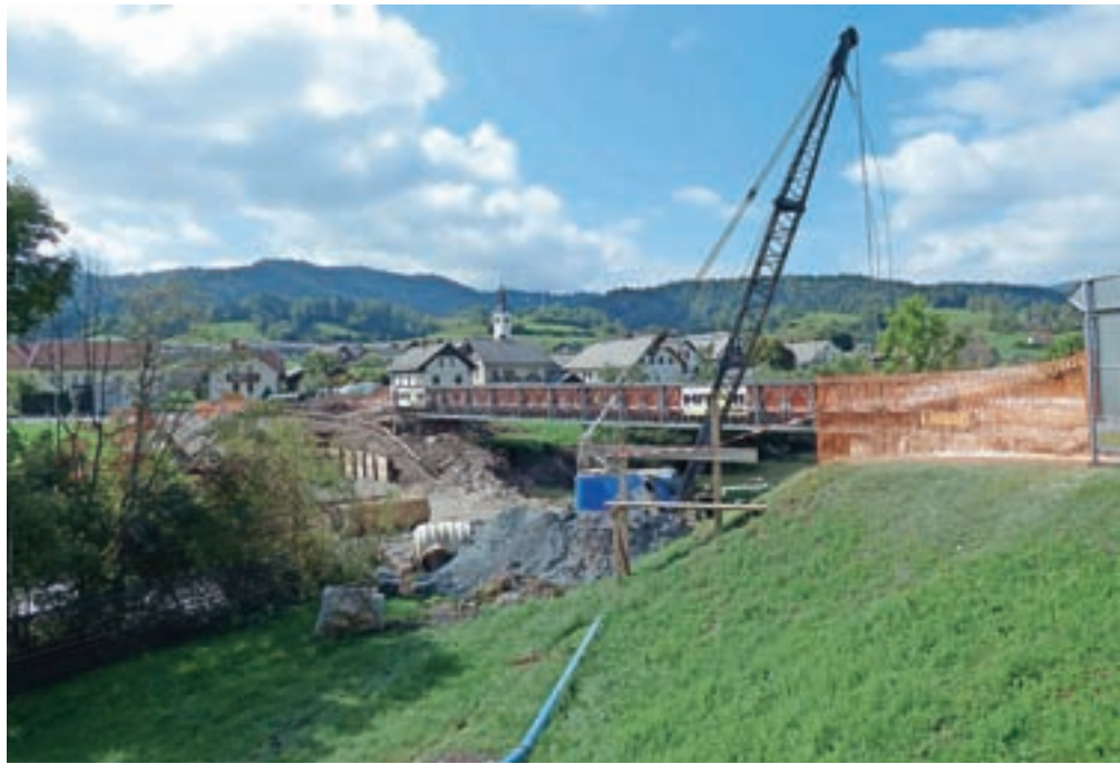
V Gorenji vasi se je začela gradnja novega mostu čez Poljansko Soro. / FOTO: JURE FERLAN
