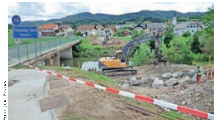
Sredi julija so začeli pripravljala dela za gradnjo novega mostu čez Poljansko Soro pri krožišču v Gorenji vasi.
