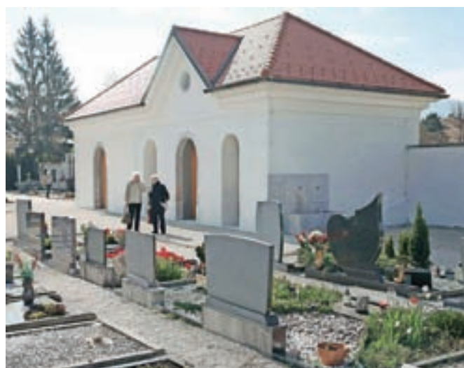
Obnovljene poslovilne vežice / FOTO: GORAZD KAVČIČ
