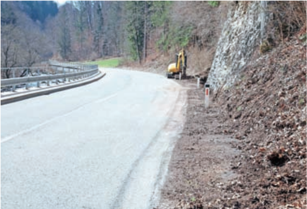
Začela se je težko pričakovana obnova ceste proti Sovodnju. / FOTO: GORAZD KAVČIČ
