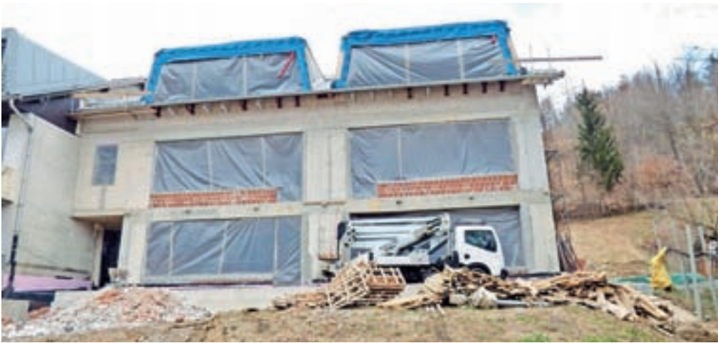
Pri gradnji novega vrtca so ta čas približno na tretjini predvidenih del. / FOTO: JURE FERLAN
