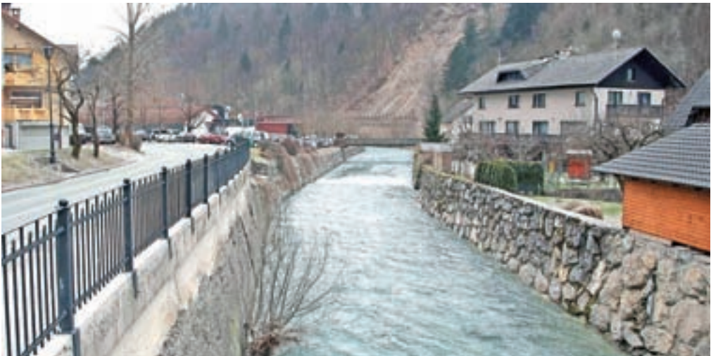
Direkcija za vode za prvo fazo protipoplavnih ureditev v Železnikih pričakuje več delnih gradbenih dovoljenj. / FOTO: GORAZD KAVIČ
