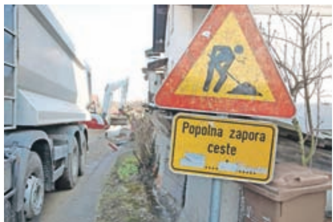
V Frankovem naselju potekajo dela pri rekonstrukciji vodovoda. / FOTO: GORAZD KAVČIČ
