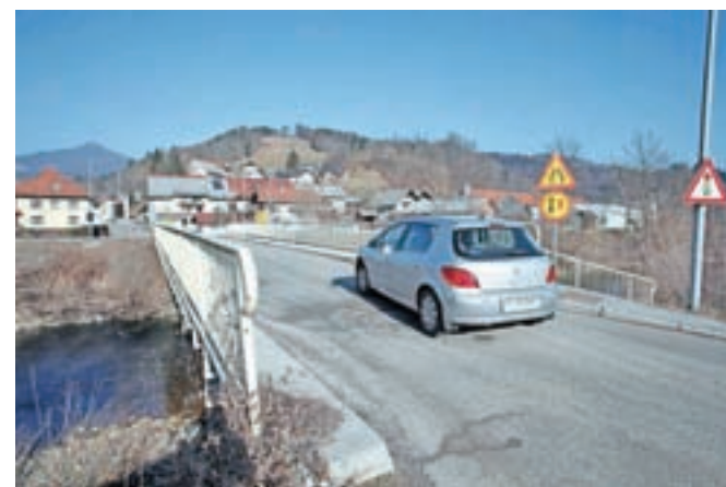
V Poljanah načrtujejo gradnjo novega mostu in krožišča. / FOTO: GORAZD KAVČIČ
