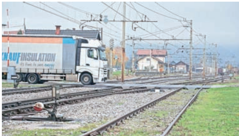
Nivojski prehod čez železniško progo še vedno uporabljajo tudi tovorna vozila. / FOTO: TINA DOKL
