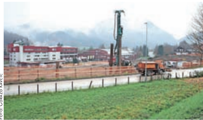
Na Dolenčevih vrtovih gradijo stanovanjsko soseko. / FOTO: GORAZD KAVČIČ
