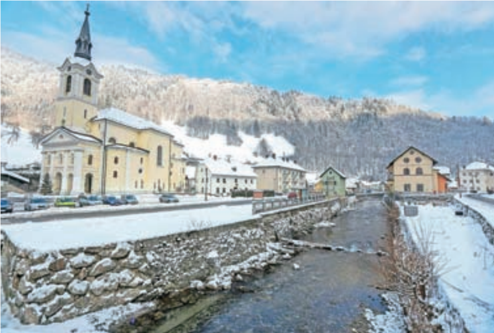
Za ureditve struge Selške Sore od Alplesa do kulturnega doma v Železnikih so že pridobili vsa soglasja lastnikov, na odseku proti plavžu pa odkupi zemljišč še potekajo. / FOTO: TINA DOKL
