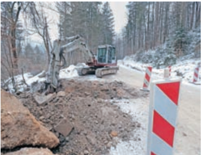
Obnova ceste v Javorje / Foto: Tina Dokl
