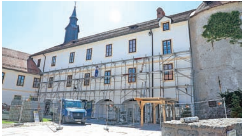
Julija so začeli obnavljati streho Loškega gradu. / FOTO: TINA DOKL
