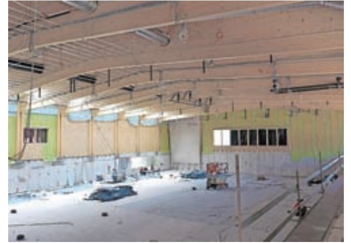
Nova dvorana je pod streho, zdaj potekajo dela v notranjosti.
