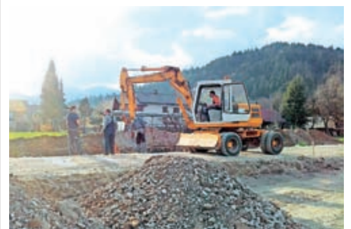
Gradnja kanalizacije in vodovoda za gasilski dom v Selcih
