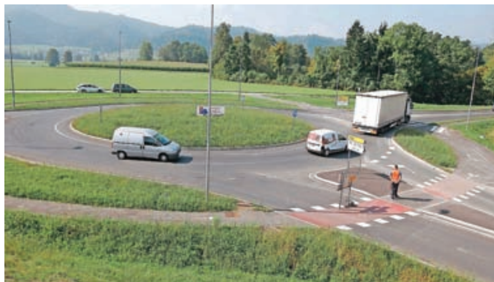
Zgrajeno je bilo tudi novo krožno križišče, kjer se dovozna cesta v industrijsko cono navezuje na regionalno cesto. / FOTO: GORAZD KAVČIČ
