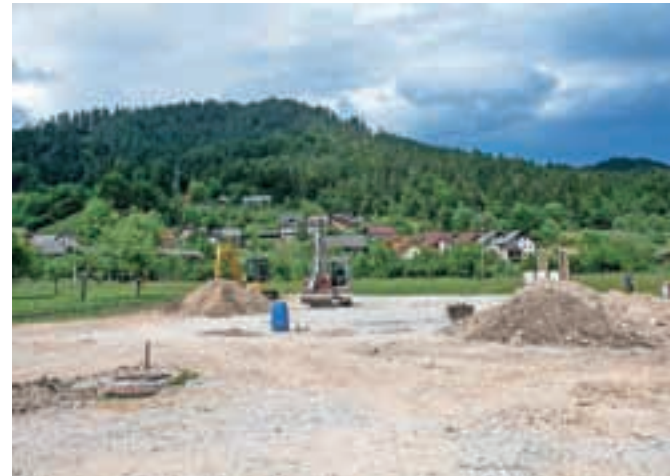
V Dolenji vasi se je pred dnevi začela gradnja športnega igrišča. / FOTO: ANDREJ TARFILA
