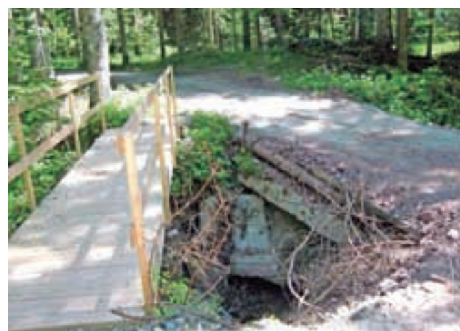
Čez potok v Plastuhovi grapi je odslej možno tudi z avtom.
