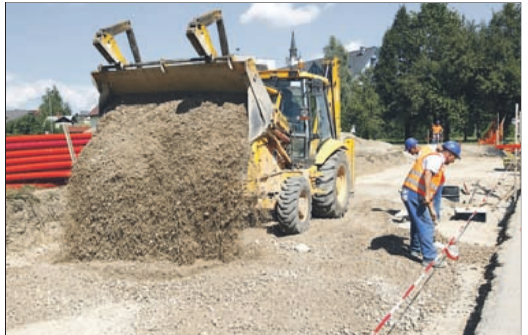
Na občinskem zemljišču v Podlubniku pospešeno pripravljajo teren za postavitev mobilne enote vrtca Biba. FOTO: GORAZD KAVČIČ
