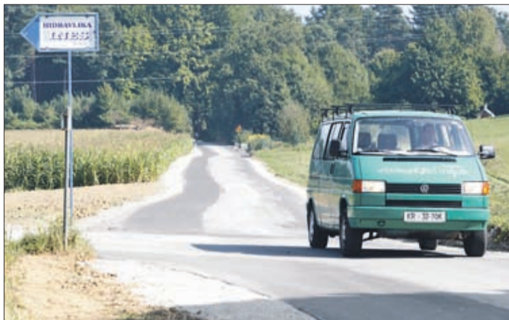
Obnovljena cesta skozi Gorajte je lepša in širša. | FOTO: GORAZD KAVČIČ
