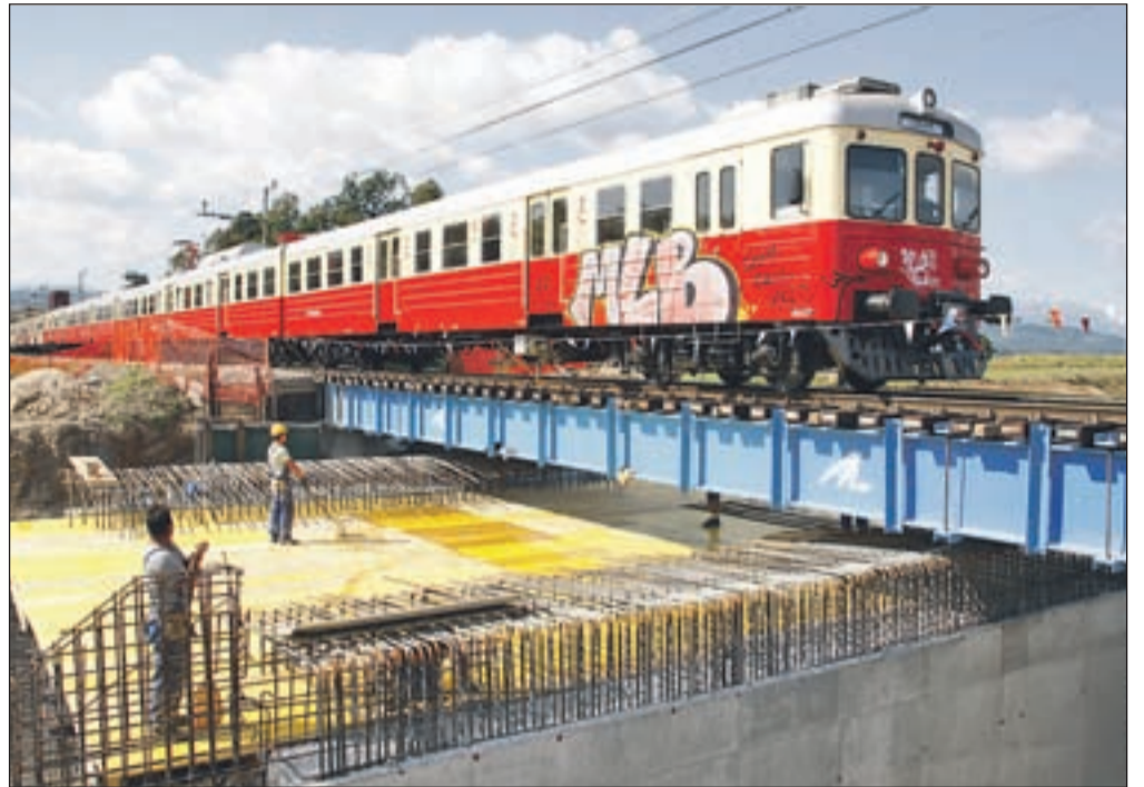
Najzahtevnejša faza pri gradnji industrijske cone na Trati. | FOTO: GORAZD KAVČIČ
