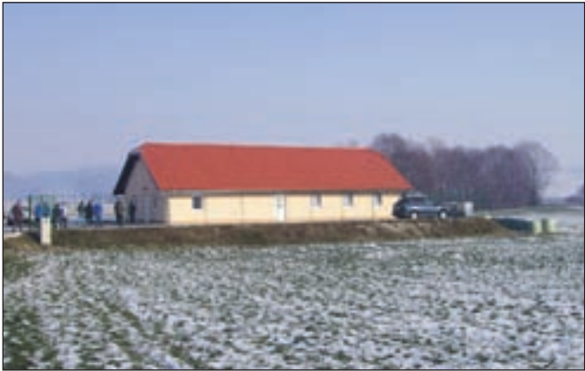
Čistilna naprava v Beli Cerkvi je takšna, kakršna je predvidena v Retečah.
