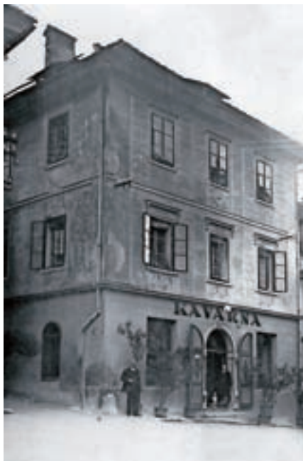
V prostorih, kjer je danes delavnica, je več kot sto let delovala kavarna.
