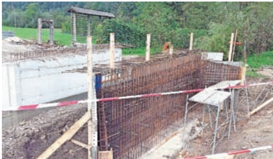
Na relaciji Ševlje–Bukovščica bodo obnovili štiri mostove. / Foto: Davor Prelogar
