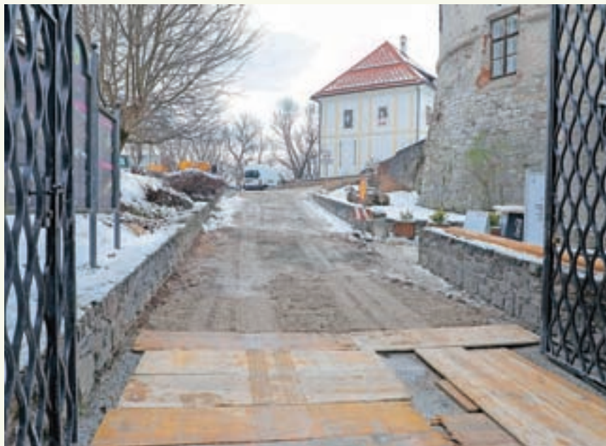
Ureditev dela dvorišča in dostopne poti na Loški grad z naravnimi materiali
