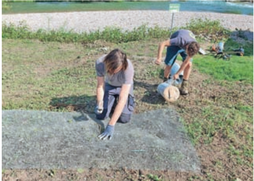
Pritrjevanje pocinkane mreže v Puštalu
