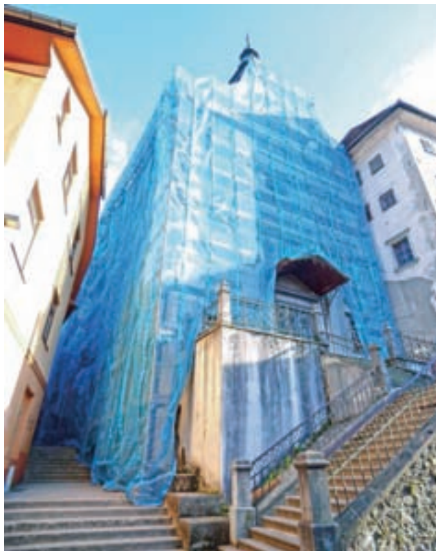
Gradbeni odri prekrivajo fasado, ki bo dobila svežo podobo.
