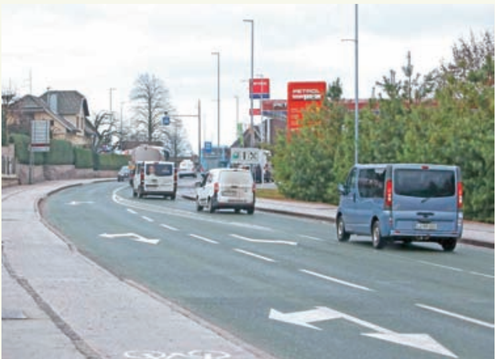
Nadaljevanje del na Kidričevi cesti od Starega dvora proti železniški postaji je predvideno v poletnih mesecih.
