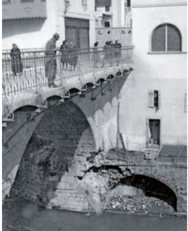
Ob umiku jugoslovanske vojske so 10. aprila 1941 v Škofji Loki razstrelili vse mostove, razen Kapucinskega, ki pa je bil močno poškodovan (hrani Loški muzej Škofja Loka).
