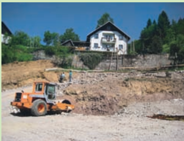
Gradnja športnega igrišča na Sovodnju se bo zaradi nepredvidenega plazenja tal nekoliko zavlekla, predvsem pa podražila.
